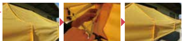
固定ベルトを引っ張りますと斜面の緩みが無くなり、生地がピンと張る為、雨が流れやすくなります。
